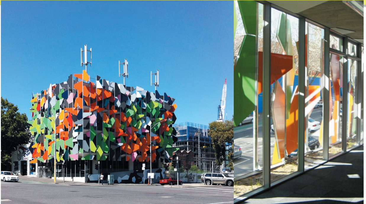
호주의 그로콘이 지은 픽셀빌딩은 100% 에너지 자급 빌딩으로 나뭇잎 모양의 '스마트 그늘막'이 주렁주렁 달린 외관이 독특하다. 사진제공_ Grocon
