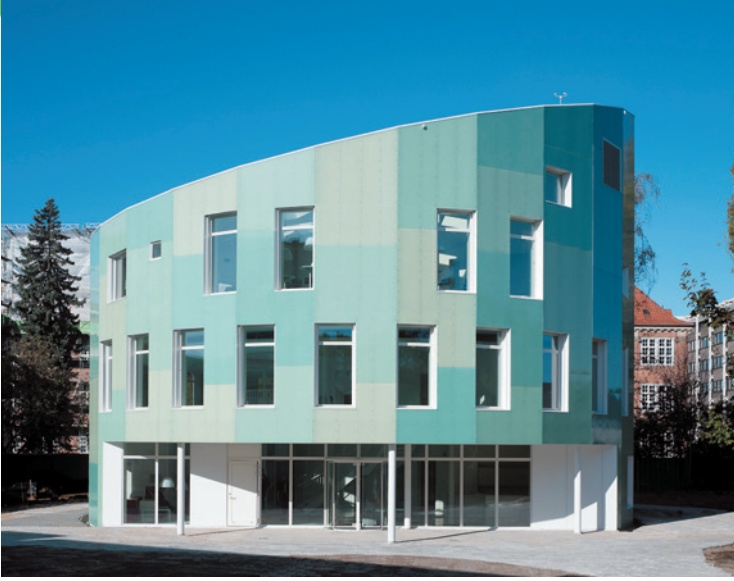
그린 라이트하우스는 원통형 외관과 창문이 태양의 이동에 맞춰 최대한 태양열을 흡수하도록 설계됐다. 나선형으로 배열된 작은 지붕 청들은 뜨거운 공기를 빠르게 배출시키는 역할을 한다. 사진제공_ Green Lighthouse
