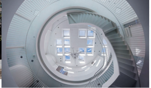
그린 라이트하우스는 원통형 외관과 창문이 태양의 이동에 맞춰 최대한 태양열을 흡수하도록 설계됐다. 나선형으로 배열된 작은 지붕 청들은 뜨거운 공기를 빠르게 배출시키는 역할을 한다. 사진제공_ Green Lighthouse
