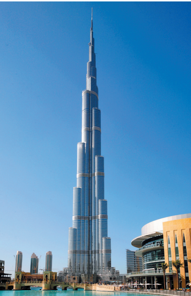
세계 최고층 빌딩 부르즈 칼리파는 뜨거운 햇볕에 실내온도가 상승하는 것을 막고자 고효율 음영유리창을 달고 입구에는 자동 햇빛차단장치를 설치했다. DPA_연합뉴스
