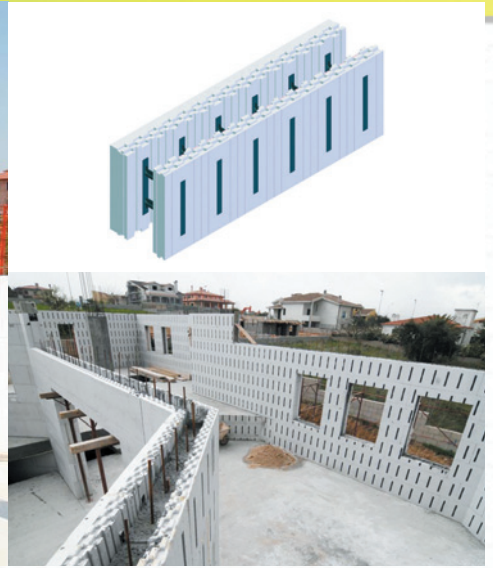
레고에서 아이디어를 얻은 클리마블록은 98%가 공기로 구성된 폴리스티렌 재질로 무게가 가볍고 시공이 매우 간단하다. 블록을 연결해 외벽을 만든 후 사이에 철골구조를 넣고 시멘트를 부으면 끝이다. 사진제공_ Pontarolo Engineering
